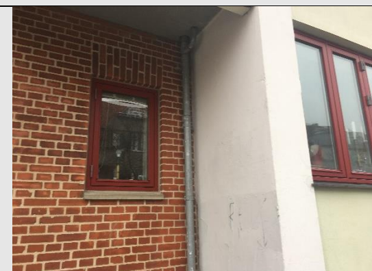
Vindue i gadefacade.
