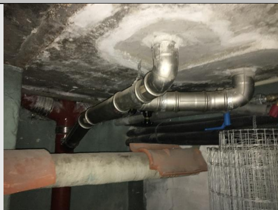
In-situ støbt etageadskillelse mod kælder.
