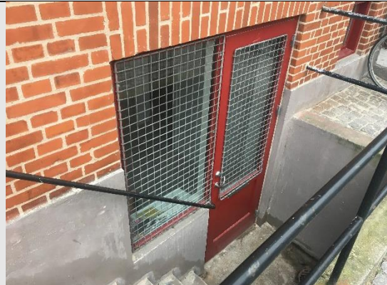
Kælderdør mod gade.
