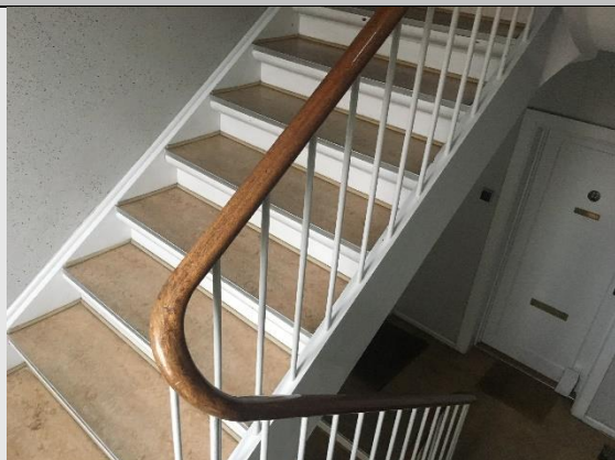
Diverse overflader i hovedtrapperum.
