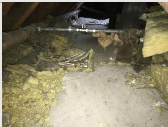
Isoleret etageadskillelse mod spidsloft.
