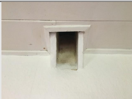
Aftrækskanal i loft i bolig.
