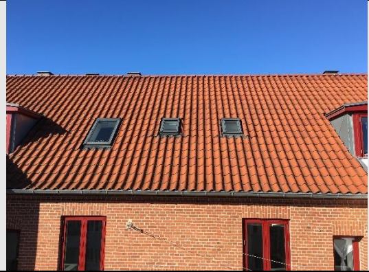
Tagvinduer mod gade.
