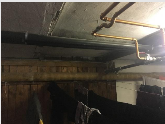
In-situ støbt etageadskillelse mod kælder.
