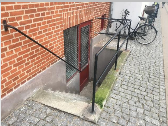
Kældernedgang mod gade.
