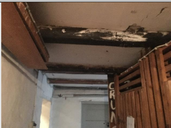
Pudset loft, etageadskillelse mod kælder.
