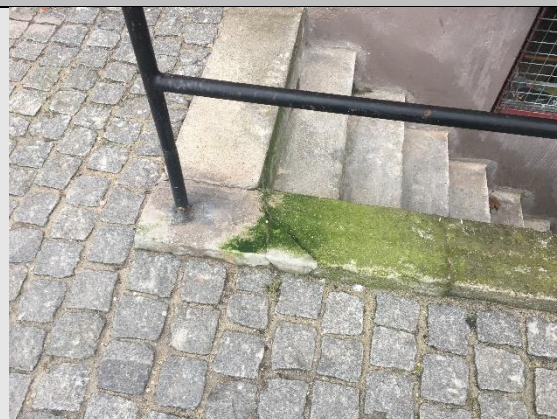
Medtagede vanger, kældertrappe mod gade.
