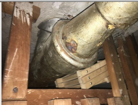
Støbejernsfaldstamme i kælderplan
