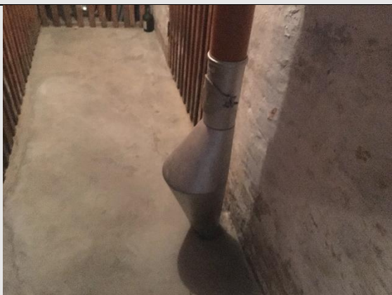
Faldstamme med rottestop i kælderplan
