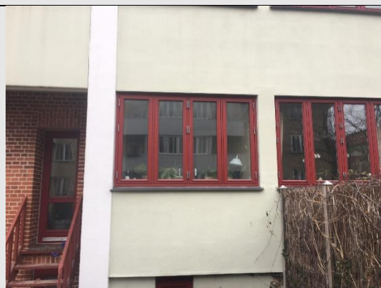
Vindue i gadefacade.
