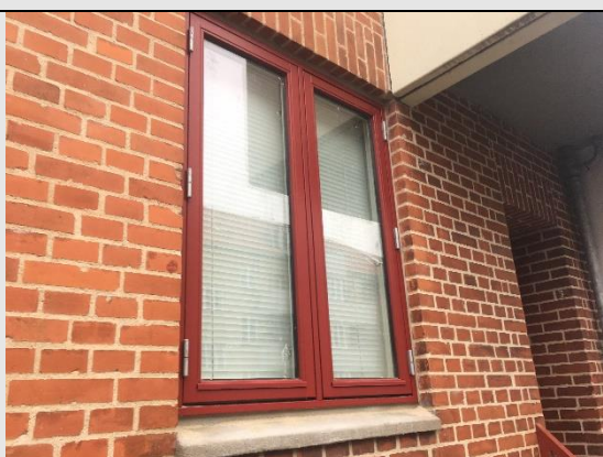
Vindue i gadefacade.
