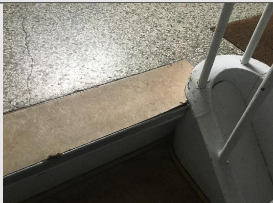
Mindre medtagede overflader på trapper.
