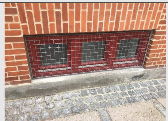
Kældervindue mod gade.
