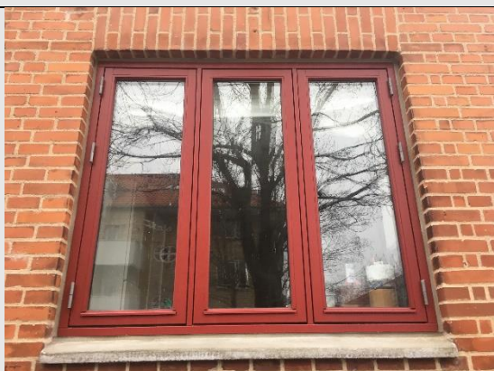
Vindue i gadefacade.
