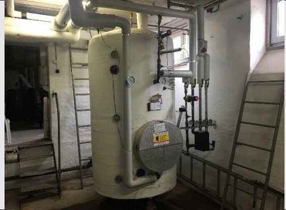
Varmtvandsbeholder
