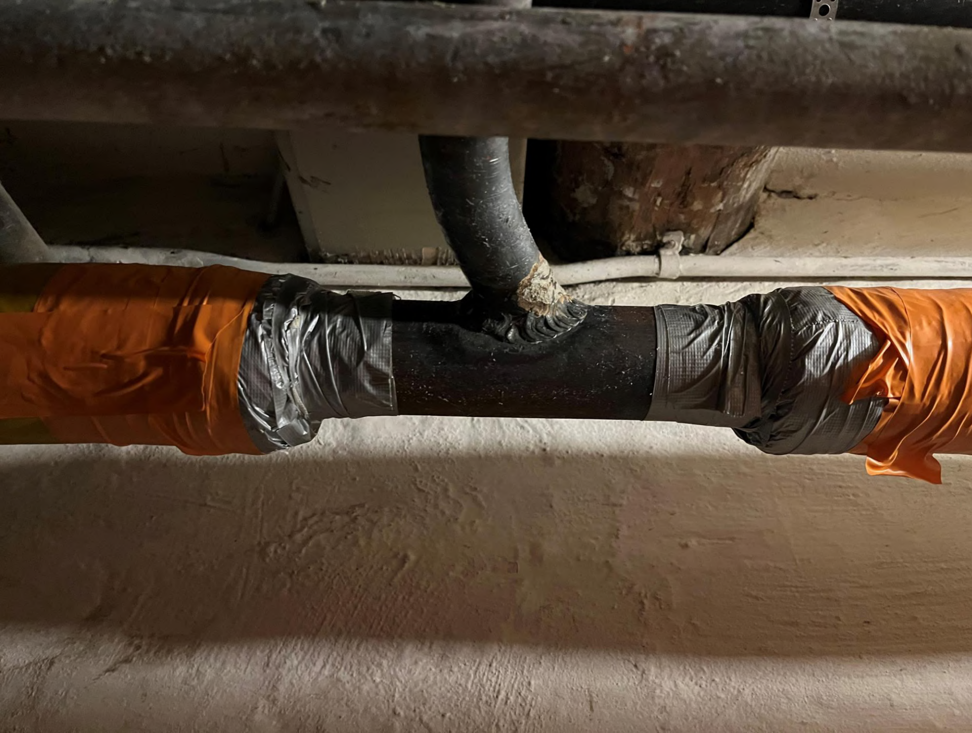
Foto 4: Skæresnit efter asbestholdig isolering er fjernet
