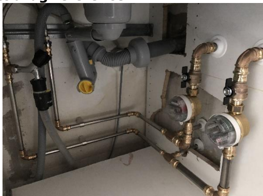
Vandmålere placeret i køkkenskab
