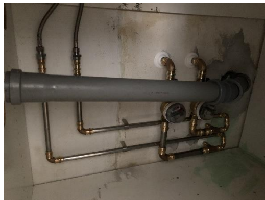
Vandmålere placeret i køkkenskab
