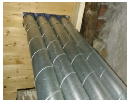
spirorør før isolering
