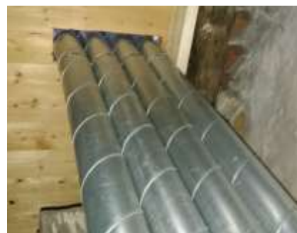
spirorør før isolering
