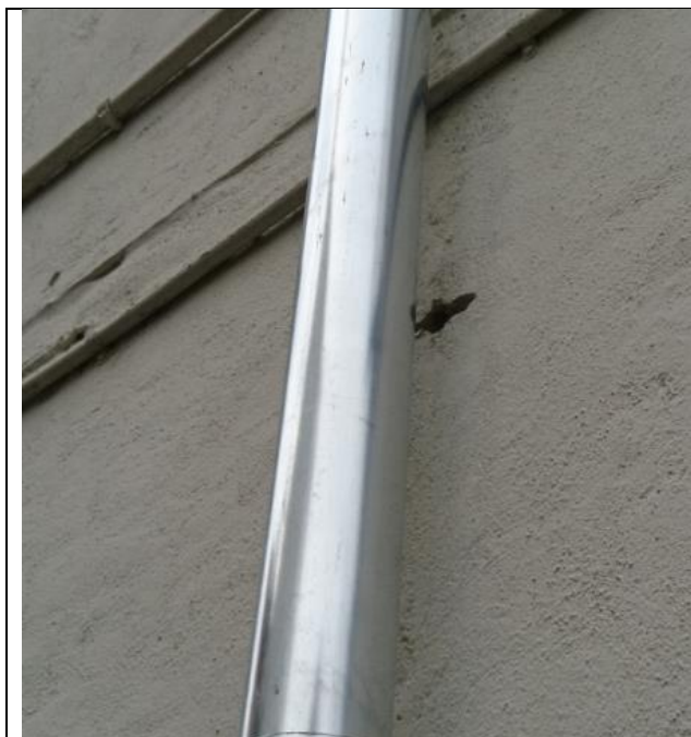
1. billede af skade efter udtagning af tidligere nedløbs fastgørelse
