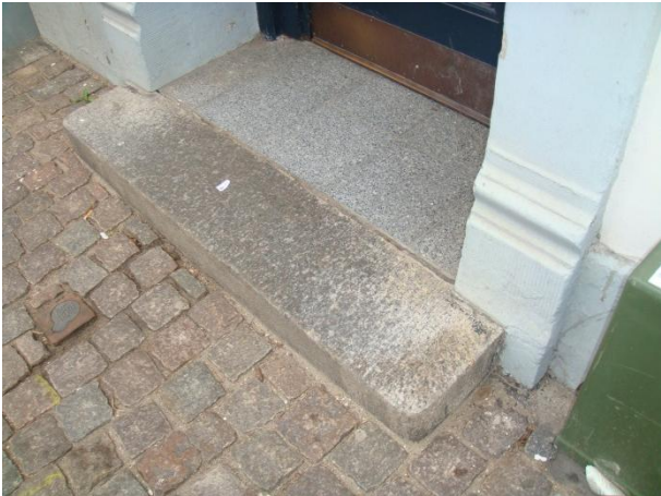
Sætning af indgangstrin samt belægning
