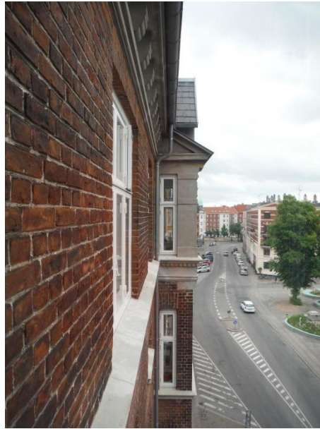
Partielt renoveret overfacade
