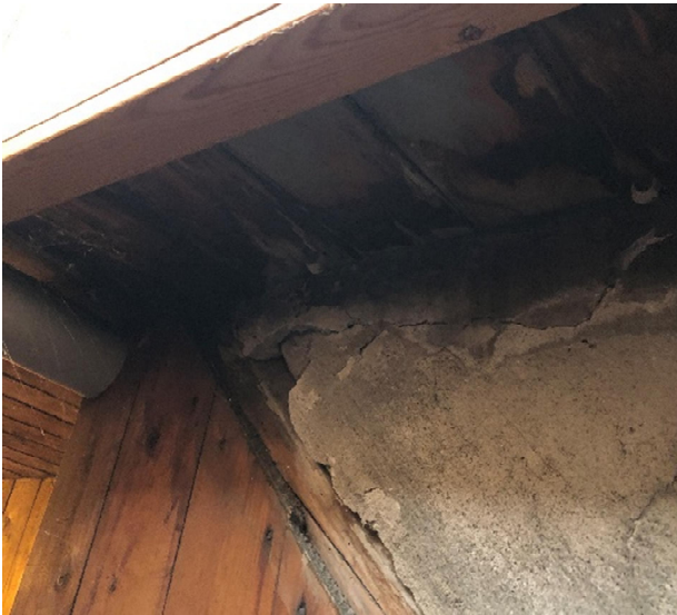
Opfugtet bræddebeklædning
