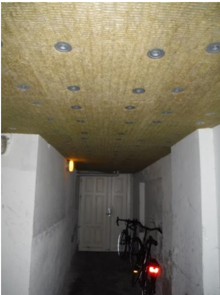
Isoleret etagedæk mod stueetagen
