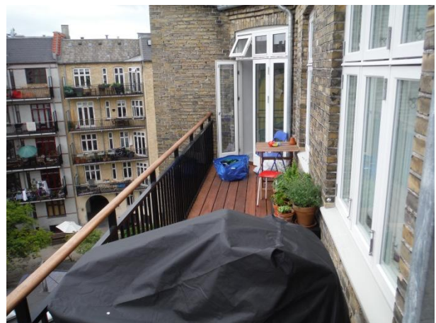
Træ/alu-vinduer mod gård
