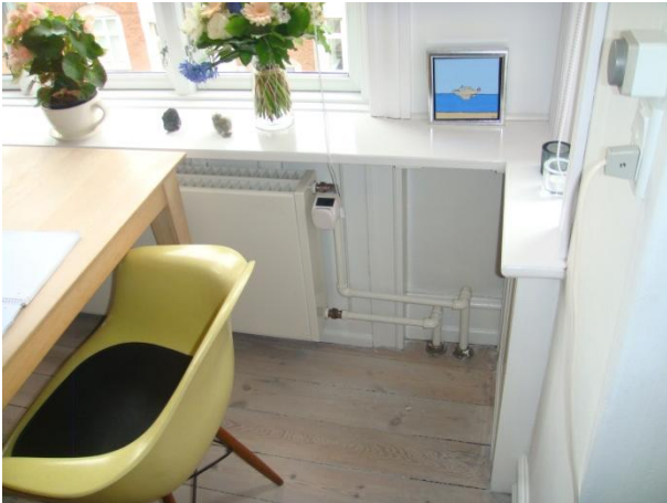
Radiatorer udskiftet i 1996
