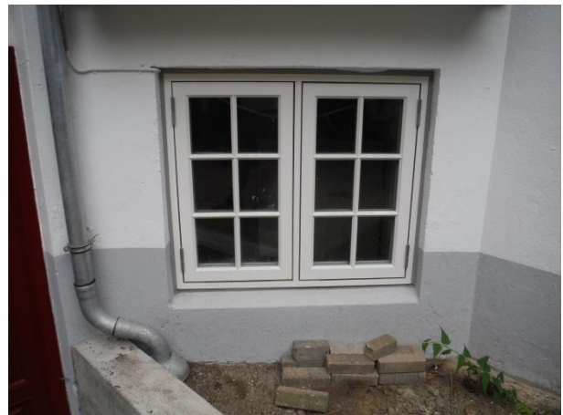
Træ/alu-vinduer mod gård
