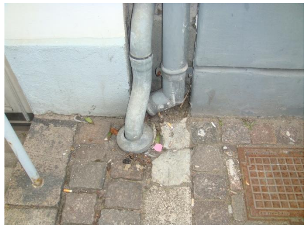
Nedløb fra naboejendom leder vand direkte mod sokkel.
