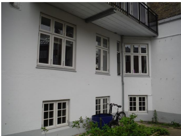
Træ/alu-vinduer mod gård
