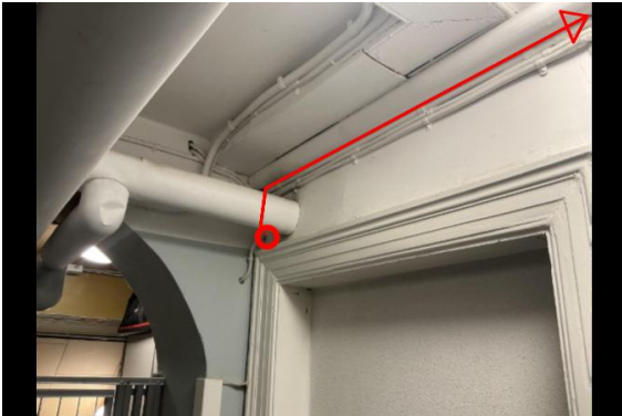
Bemærkninger til billede: Fiberen bores ud på bagtrappe
