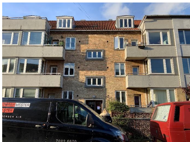
Facade og vinduer mod gade.
