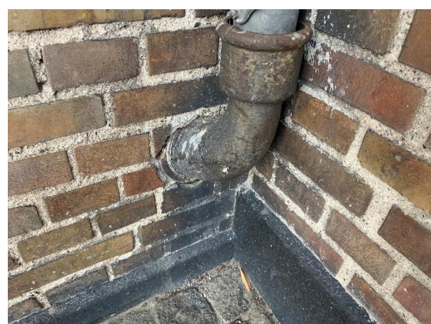
Tagvand ført gennem mur mod Mozartsvej.
