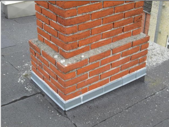
Skorsten med zinkinddækning
