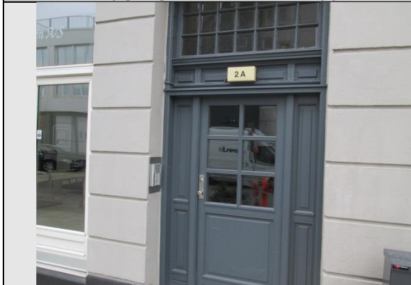
Opgangsdør til hovedtrappe
