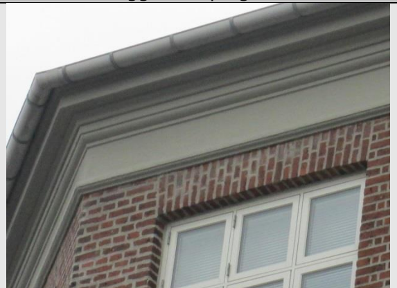
Malet taggesims på gadefacade
