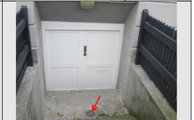
Dobbelt kælderdør på gadeside
