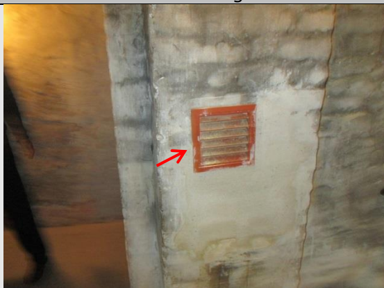
Aftræk fra kælder i gl. skorsten
