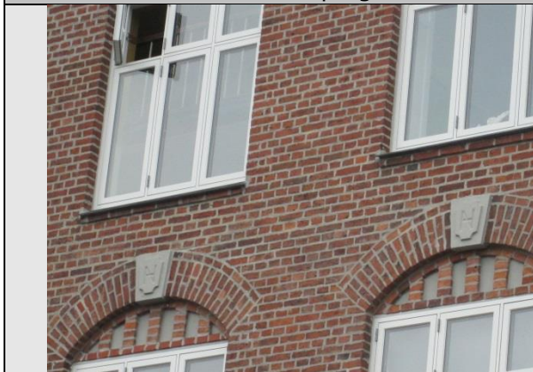
Blankt murværk på gadeside
