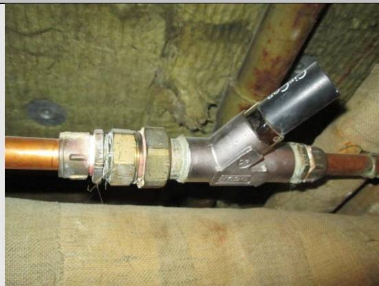
Cirkulationsventil i kældere
