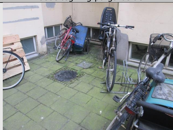
Flisebelægning på gårdsiden
