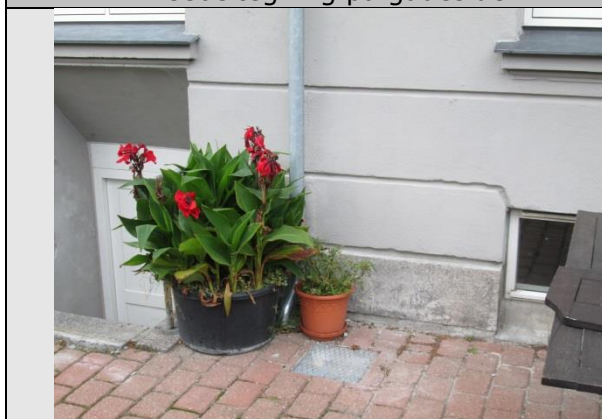
Flisebelægning på gadesiden
