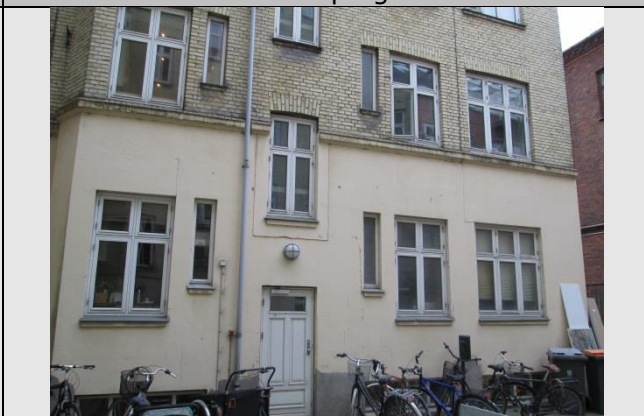
Trævinduer på gårdside
