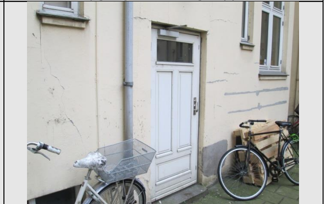
Opgangsdør til bagtrappe
