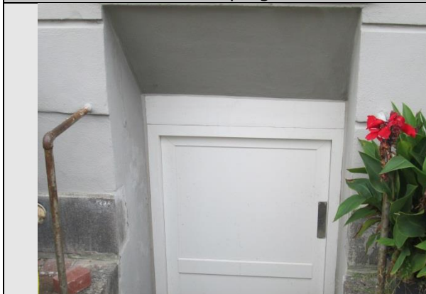
Kælderdør på gadeside
